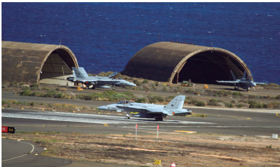
La base aérea de Gando cuenta con varios refugios reforzados en los que se alojan los cazabombarderos F/A-18 que prestan servicio en el 462 Escuadrón.
